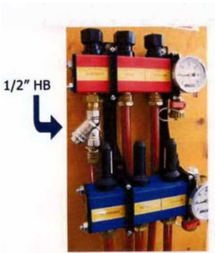
Exemple d'installation sur un collecteur de plancher chauffant
