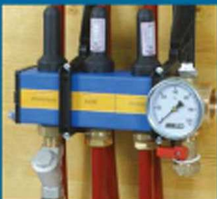
Montage sur un collecteur
